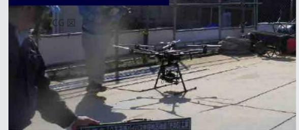
最後に施工が終わった段階で、もう一度ドローンを飛ばして3次元の出来形測量を行います。
