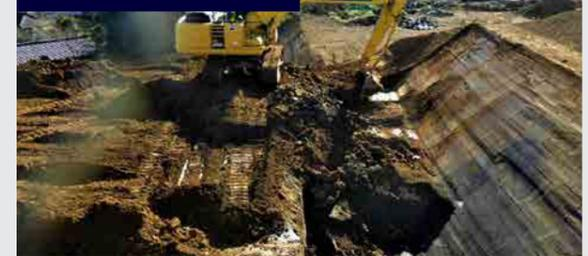
3次元設計データで読みこんだ施工領域よりも施工領域外に刃先がいかないようコントロールされています。
